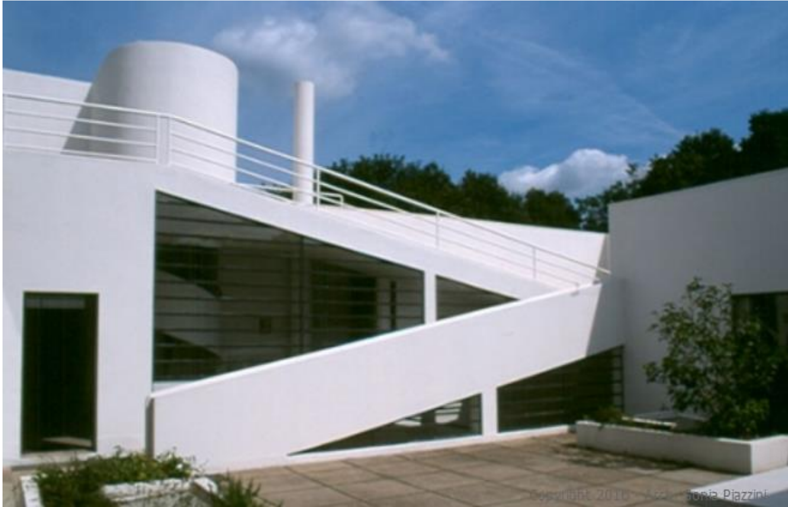
Rampa esterna, che collega il patio al giardino in copertura
